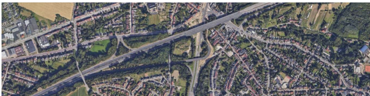
Figure 48 : Photo aérienne de la situation existante (= situation de référence) complexe de raccordement 20 (Kraainem)
