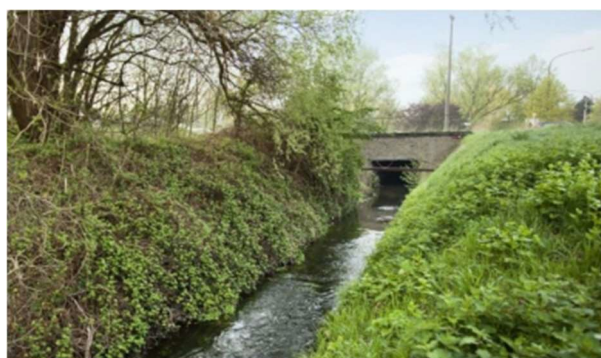
Figure 17 : Ouverture de la Woluwe à hauteur de la Chaussée de Louvain, Zaventem (Source : LIFE Belini)
