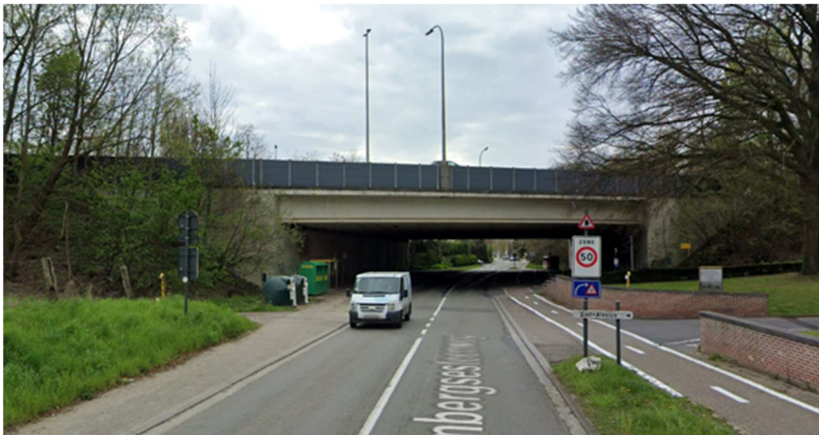
Figure 285 : Image de la Chaussée de Grimbergen - situation existante (source : Google Maps)
