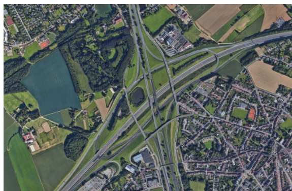
Photo 19 : Échangeur du R0/A12 (source : www.googlemaps.be )
