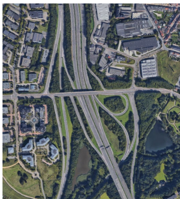
Photo 33 : Complexe de raccordement 3 H. Henneulaan (source : www.google.be/maps )
