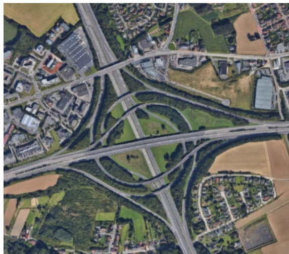
Photo 30 : Échangeur R0/E40 à Woluwe-Saint-Étienne.
