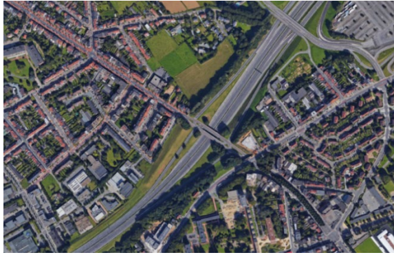
Photo 5 : Complexe de raccordement 8 Wemmel (source : www.google.be/maps )
