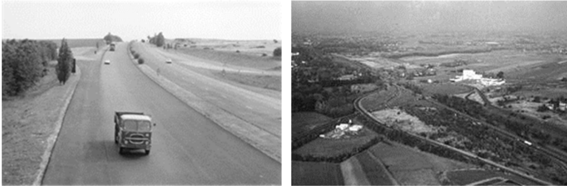
Figures 5 et 6 : À gauche : le R0 à hauteur de Wemmel (en 1967), à droite : la jonction entre le R0 et l'A12 à Strombeek-Bever (Grimbergen) (Source : AWV).
