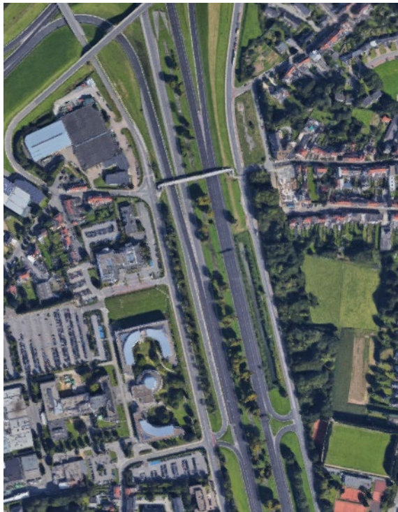
Photo 8 : Complexe de raccordement 2 sur l'A12 à Strombeek-Bever (source : www.google.be/maps )
