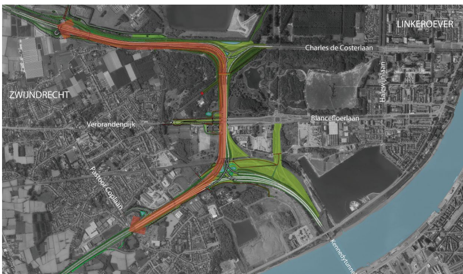
Figure 128 : Référence de travaux d'infrastructure sur la rive gauche, Anvers (OWV-Lantis)
