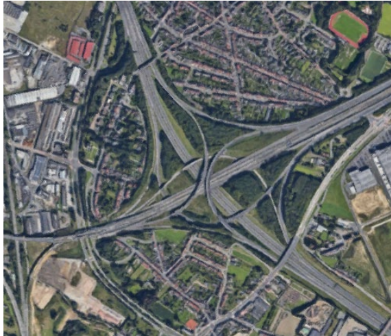
Photo 20 : Échangeur du R0/E19 (source : www.googlemaps.be )
