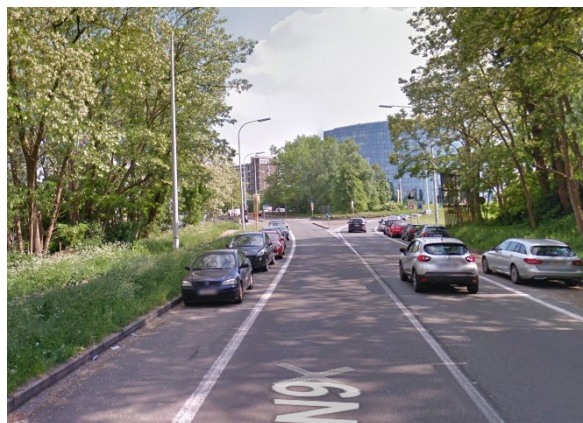
Photo 11 : N9 au niveau de l'embranchement avec l'A10 (source : www.google.be/maps )
