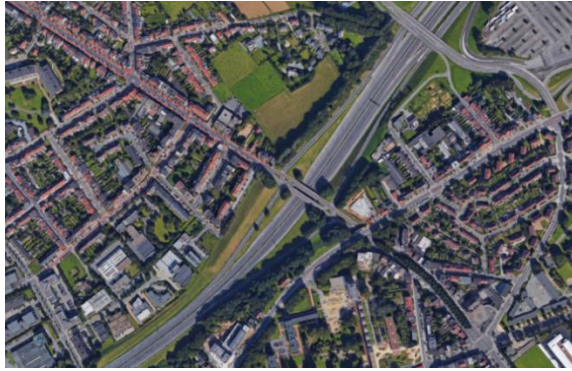
Photo 5 : Complexe de raccordement 8 Wemmel (source : www.google.be/maps )
