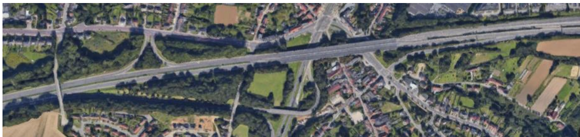
Photo 35 : Complexe de raccordement 20 sur l'A3/E40 à Crainhem (source : www.google.be/maps )
