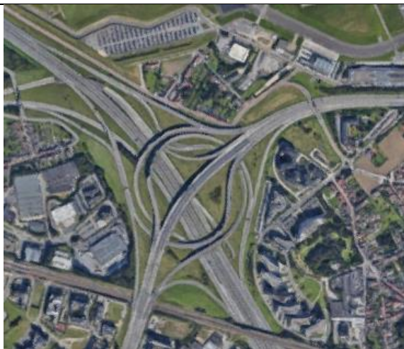
Photo 31 : Échangeur du R0/A201 (source : www.googlemaps.be )
