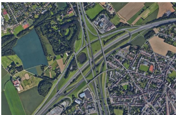
Photo 19 : Échangeur du R0/A12 (source : www.googlemaps.be )
