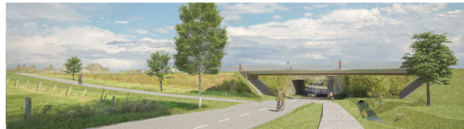
Possible scénario futur de la rampe pour vélos qui mènera à la piste cyclable du Ring à hauteur de la Kattebroekstraat. La rampe pour vélos sera construite sur la bretelle de sortie amenée à disparaître.
