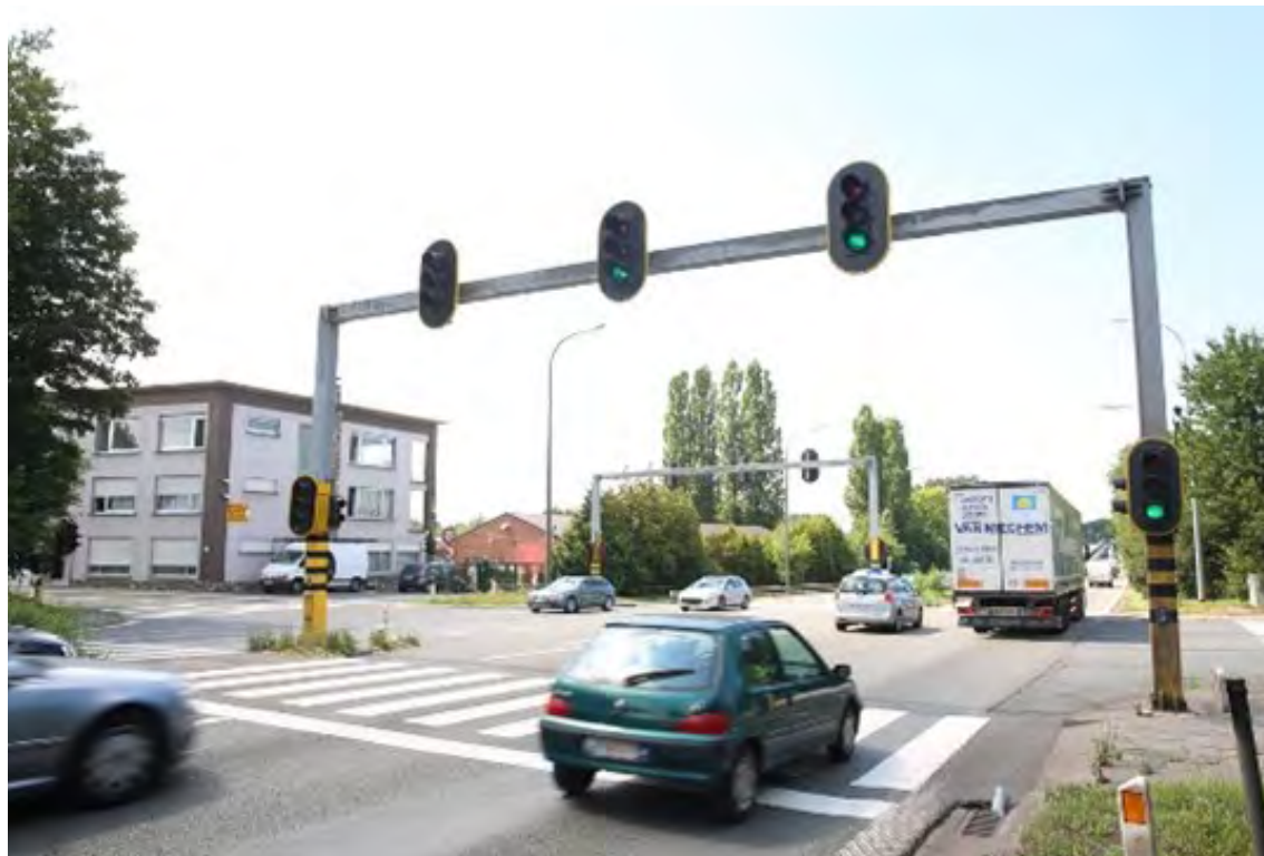
Figure 2 : Carrefours dangereux sur l'A8 à Hal (Photo carrefour A8 © Mozkito).
