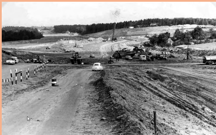
« Construction de la sortie Hal avec l'autoroute E429 vers 1970 (Eddy Deknop). »
