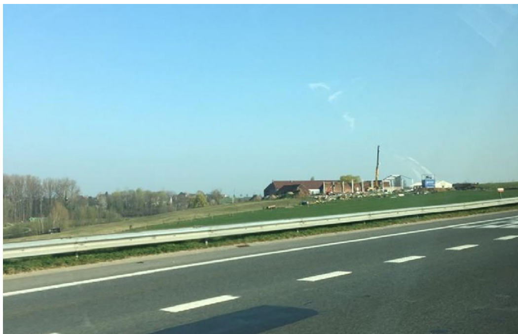
Figuur 11-135: Zicht vanaf de R0 op de in uitvoering zijnde werken voor de bouw van een loods t.h.v. hoeve Hooghof (foto genomen dd. 26/03/2022)
