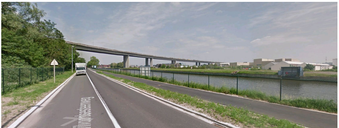
Zicht op Viaduct van Vilvoorde vanaf Vilvoordsesteenweg (zuidzijde)
