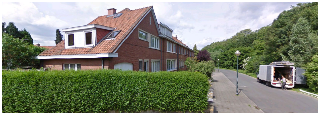
Groenbuffer tussen wijk Voor en R0, gezien vanuit het oosten
