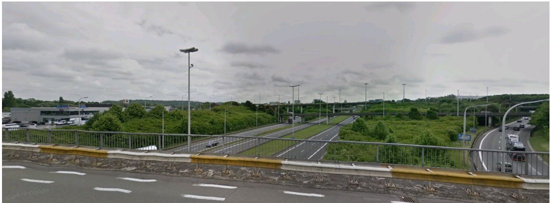
Zicht op verhoogde knoop Groot-Bijgaarden (E40 west) vanaf brug Raymond Pelgrims de Bigardlaan (westzijde)
