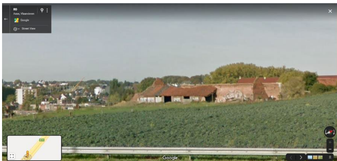
Figuur 11-134: Zicht vanaf de R0 op de in mindere staat zijnde langsschuur van de hoeve Hooghof (bron: Google Streetview)
