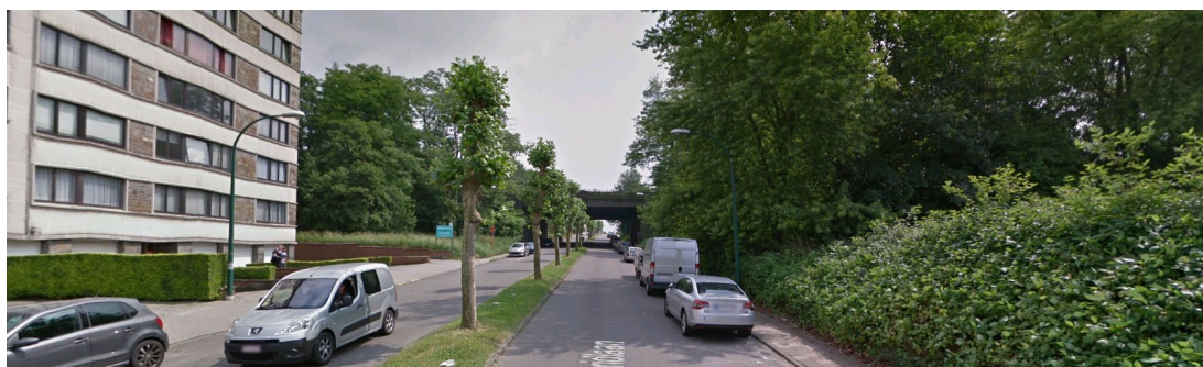
Woningen Koningin Astridlaan nabij onderdoorgang onder R0 (gezien vanuit het noorden)
