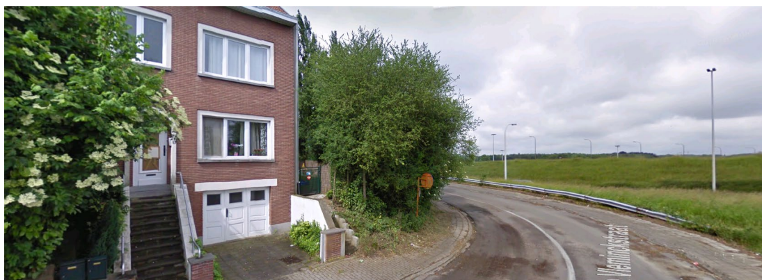
Woning van Strombeek op slechts 35m van “reuzenvonde”
