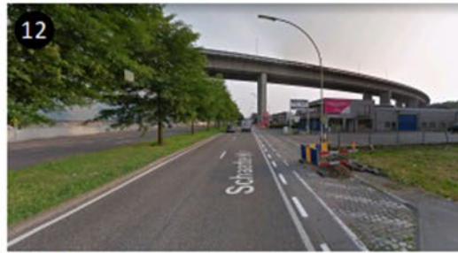
Zicht op het viaduct
