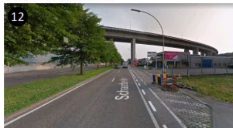
Zicht op het viaduct
