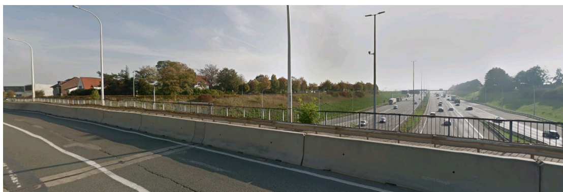
Wooncluster Felix Timmermanslaan en R0 gezien vanaf brug N21 Haachtsesteenweg (westen)
