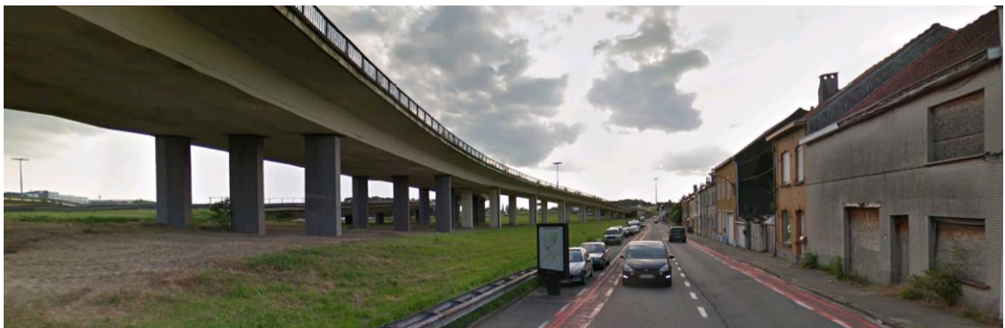
Wooncluster Diegem-Lo naast viaduct dat deel uitmaakt van knoop A201 (af te breken i.k.v. “quick win”)
