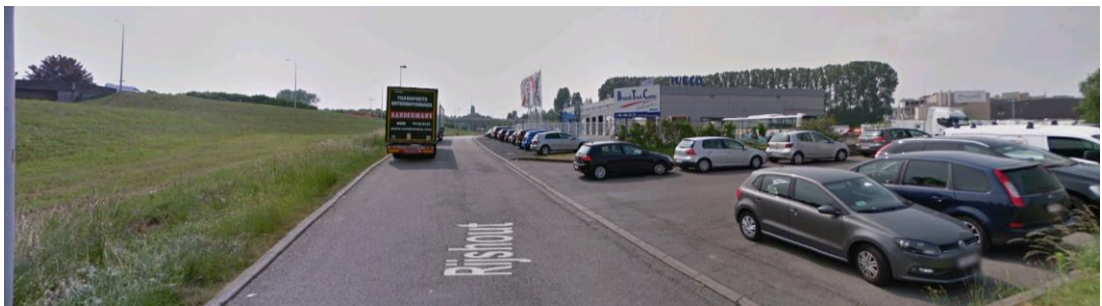
Bufferstrook en wegenis aan NW zijde knoop Groot-Bijgaarden (links talud verhoogde knoop)
