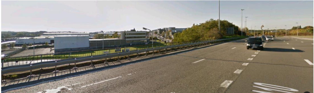
E40 binnen de ring en bedrijvzone Groot-Bijgaarden (waartussen nieuwe parkzone wordt voorzien)
