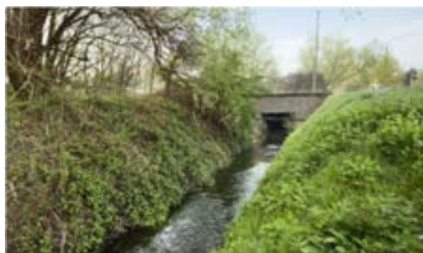
Figuur 17: Openleggen Woluwe thv Leuvensesteenweg, Zaventem (Bron: LIFE Belini)
