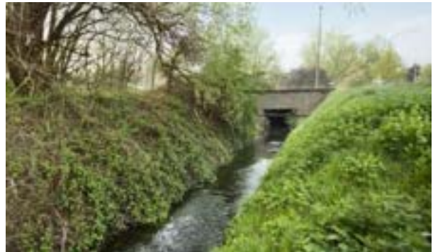
FIGUUR 13: OPENLEGGEN WOLUWE THV LEUVENSESTEENWEG, ZAVENTEM (BRON: LIFE BELINI)
