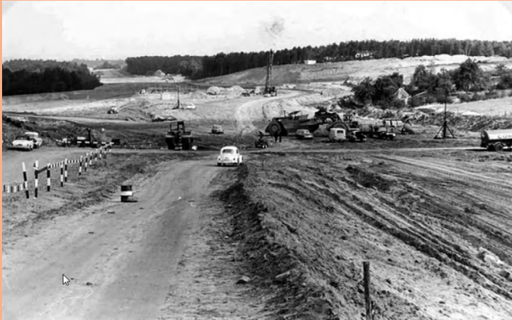
Aanleg van de afrit Halle met snelweg E429 ca. 1970 (Eddy Deknop).
